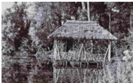
Augustin BOUTIQUE, Parc de Cuincy, détail
